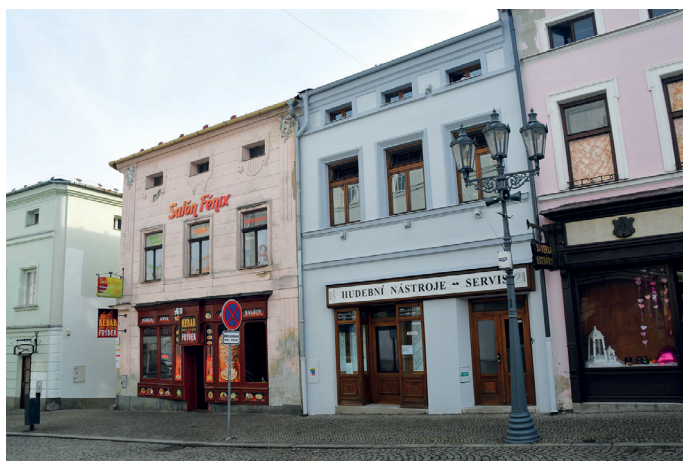
Na opačné straně frýdeckého náměstí jsou v ohrožení nájemníci bytů domu č. p. 1248.
